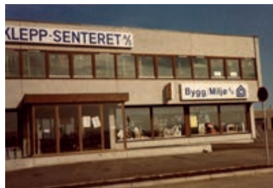
Bilde av det første senteret i Klepp der også Bygg/ Miljø holdt til i en periode.
